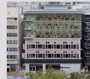
構造や耐火性能上、下層部分を非木造、上層部分を木造にした例
