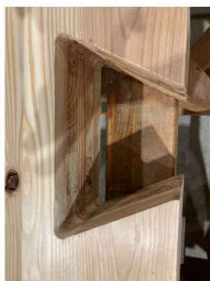
高耐力CCU アリ加工 (SAI開発) R8
