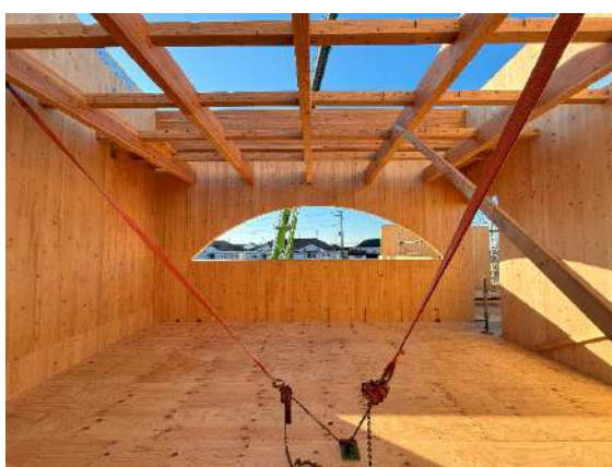
【2F CLT パネル+横架材】
