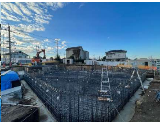
【基礎配筋状況】
