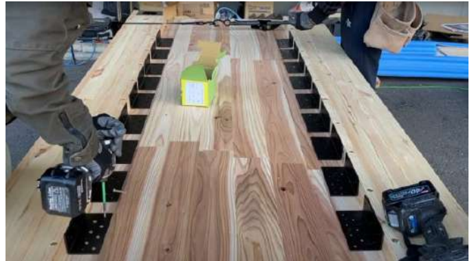
図5 柱と CLT の L 字金物での接合工程
