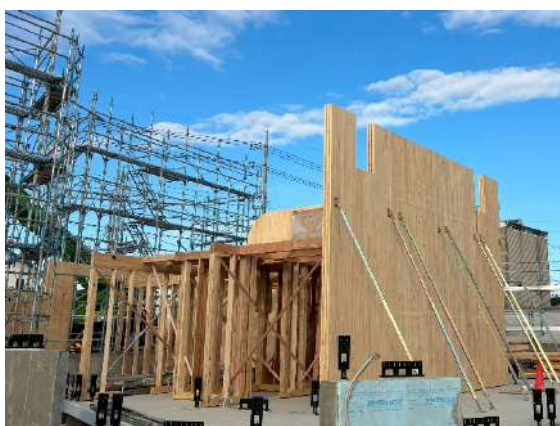
【1F 軸組+CLT パネル】
