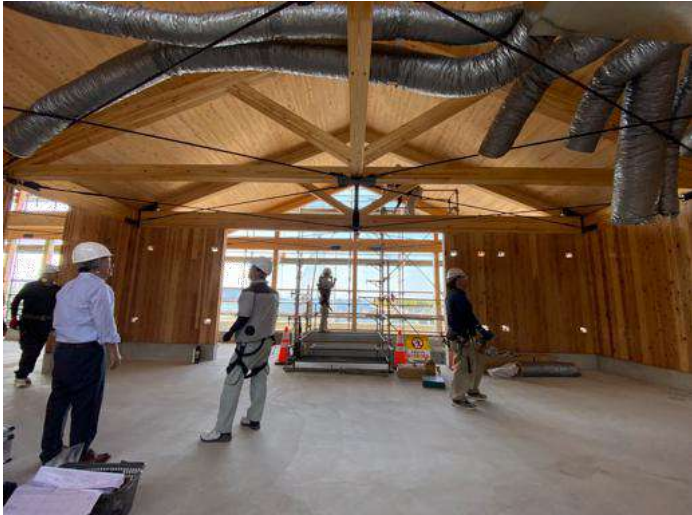
m. 建て方、CLTヒノキHBの確認
