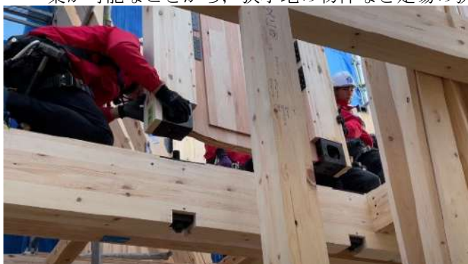
図 1 4 上階での耐力壁配置
