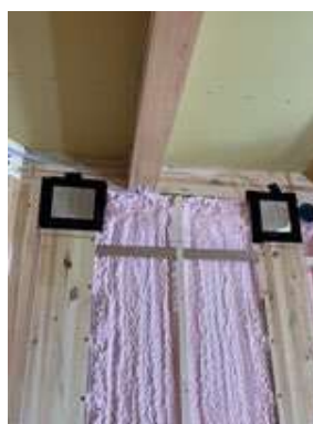
図 1 9 柱頭・柱脚金物の断熱処理
