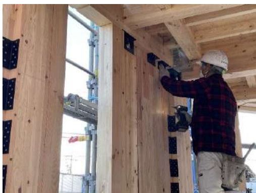
図 1 6 L 字金物での耐力壁と梁の固定工程
