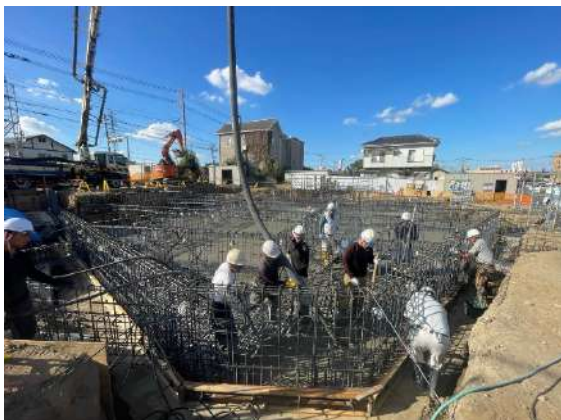
【耐圧盤コンクリート打設状況】
