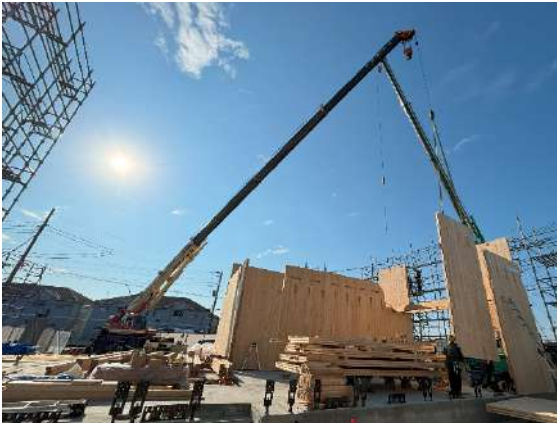
【CLT 建方状況】
