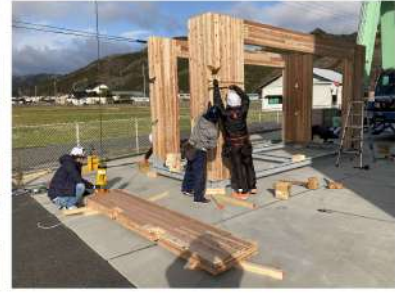
高耐力CCU組立3 (門型設置)
