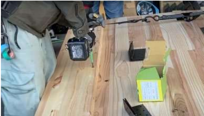
図4 柱と CLT のビス接合工程
