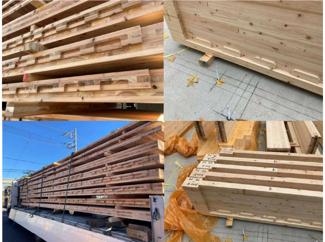
集成梁とCLTスラブの加工断面
