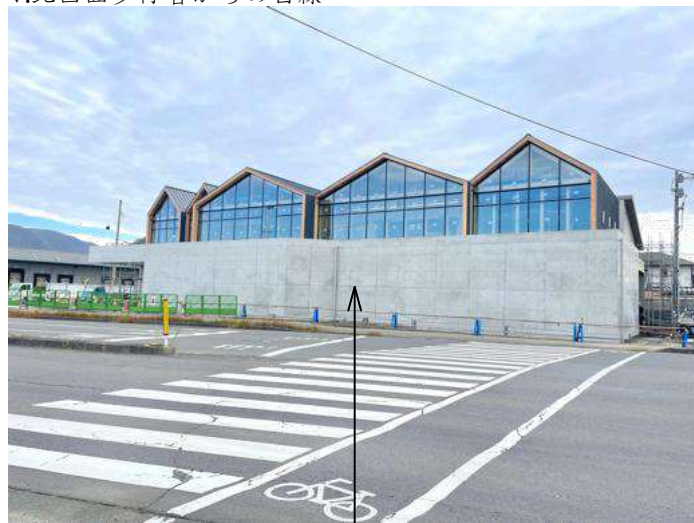
RCの上に家形が乗っており、サッシ面が強調されている
