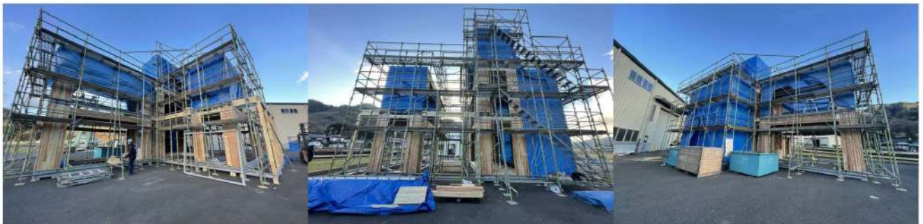
3層施工実験モデル棟1 （北東面）
