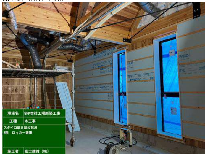
h.壁断熱施工風景
