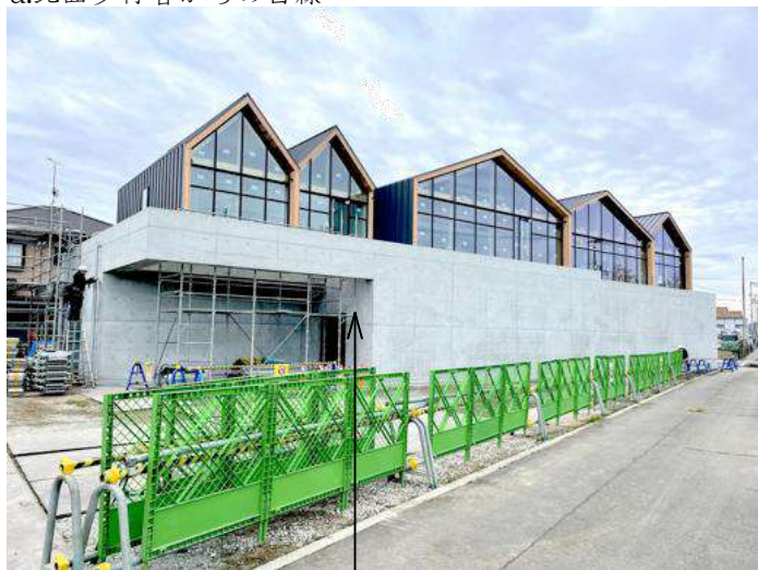
RCのエントランスとCLTの家形の屋根が見える
