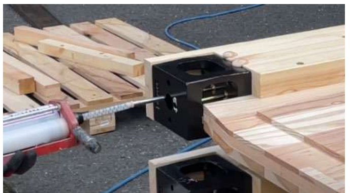
図7 接着剤の充填工程
