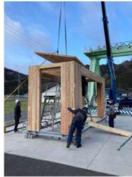
高耐力CCU組立5 (天井版設置)
