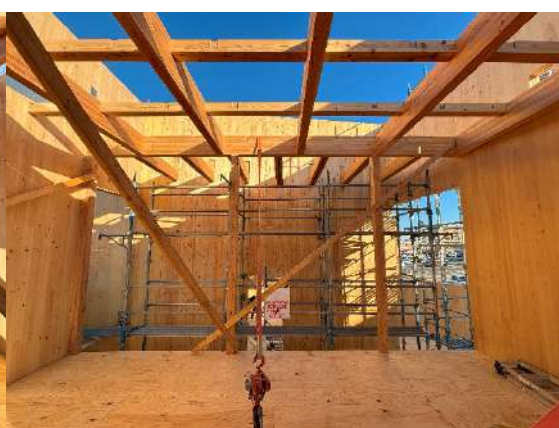
【2F CLT パネル+横架材】
