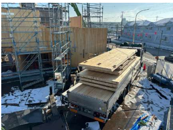
【CLT 搬入状況】
