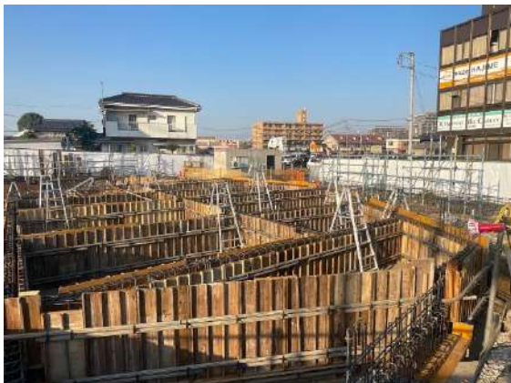
【基礎型枠建況】
