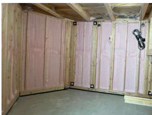
図 1 8 断熱際の吹き付け後
