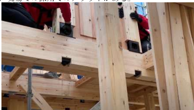
図 1 5 上階での耐力壁固定
