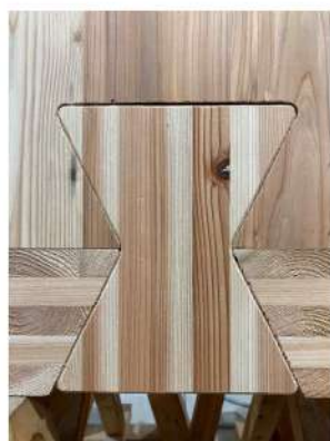
高耐力CCU 蝶蟻勘合 (SAI開発/ミヨシ加工) R8
