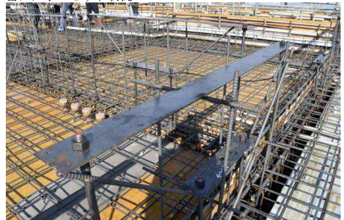
d.アンカーセット状況
