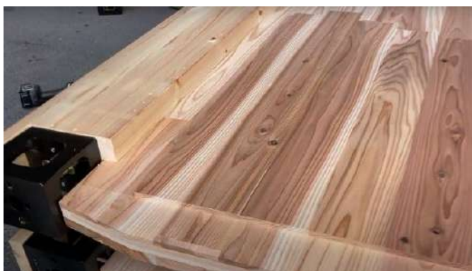
図 3 柱と CLT の接着後の様子
