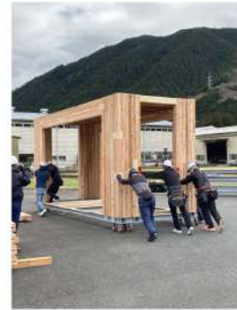
高耐力CCU組立6 (ユニット完成)
