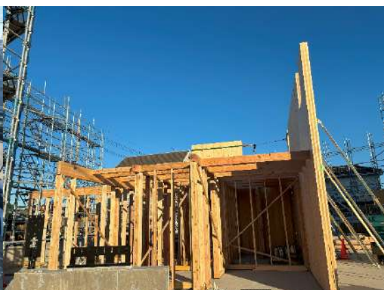
【建方状況①】
