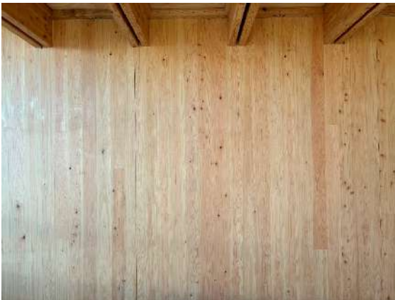
【CLT 現し (仕上げ面)】
