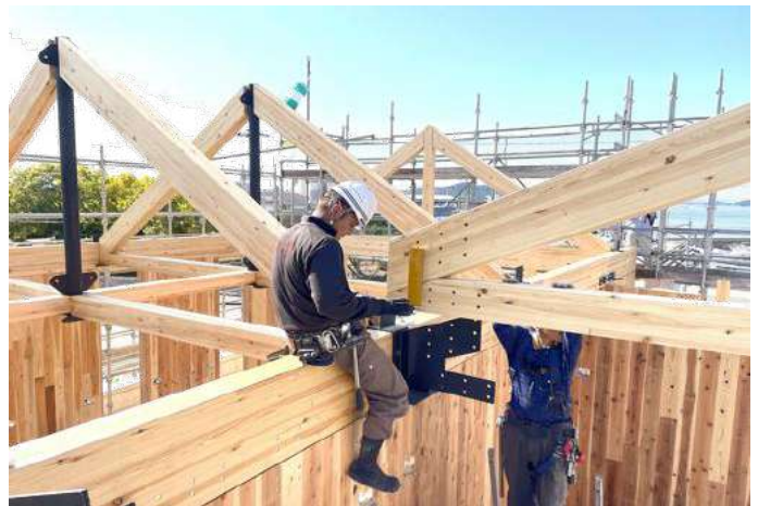
y.製作金物へトラスを落とし込み
