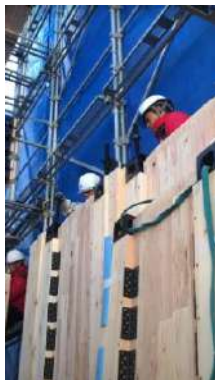
図12 柱頭へのボルト取り付け
