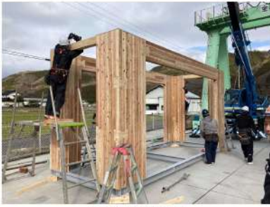
高耐力CCU組立4 (短辺側繋ぎ)
