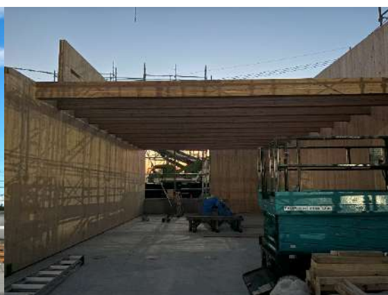
【1F CLT パネル+横架材】
