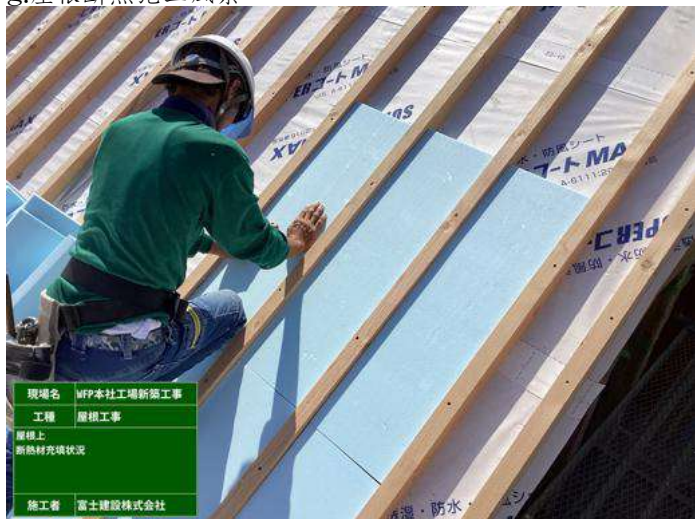
g.屋根断熱施工風景
