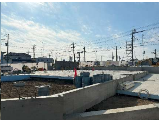
【スラブコンクリート打設完了】
