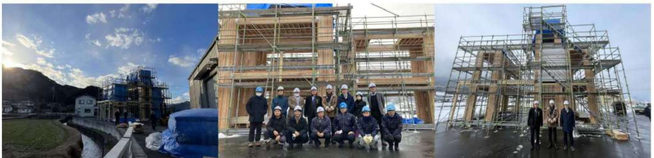
3層施工実験モデル棟4 （全景）
