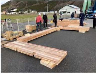
高耐力CCU組立1 (長辺側の門型組立)
