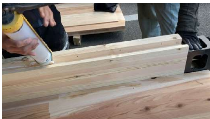
図 2 柱への接着剤塗布工程
