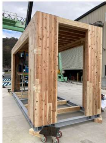
高耐力CCU (天井版取付)
