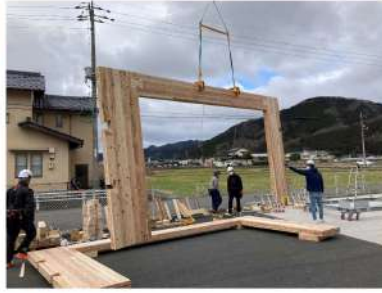
高耐力CCU組立2 (門型吊り上げ)
