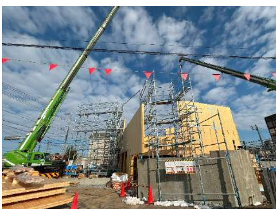
【建方状況②】
