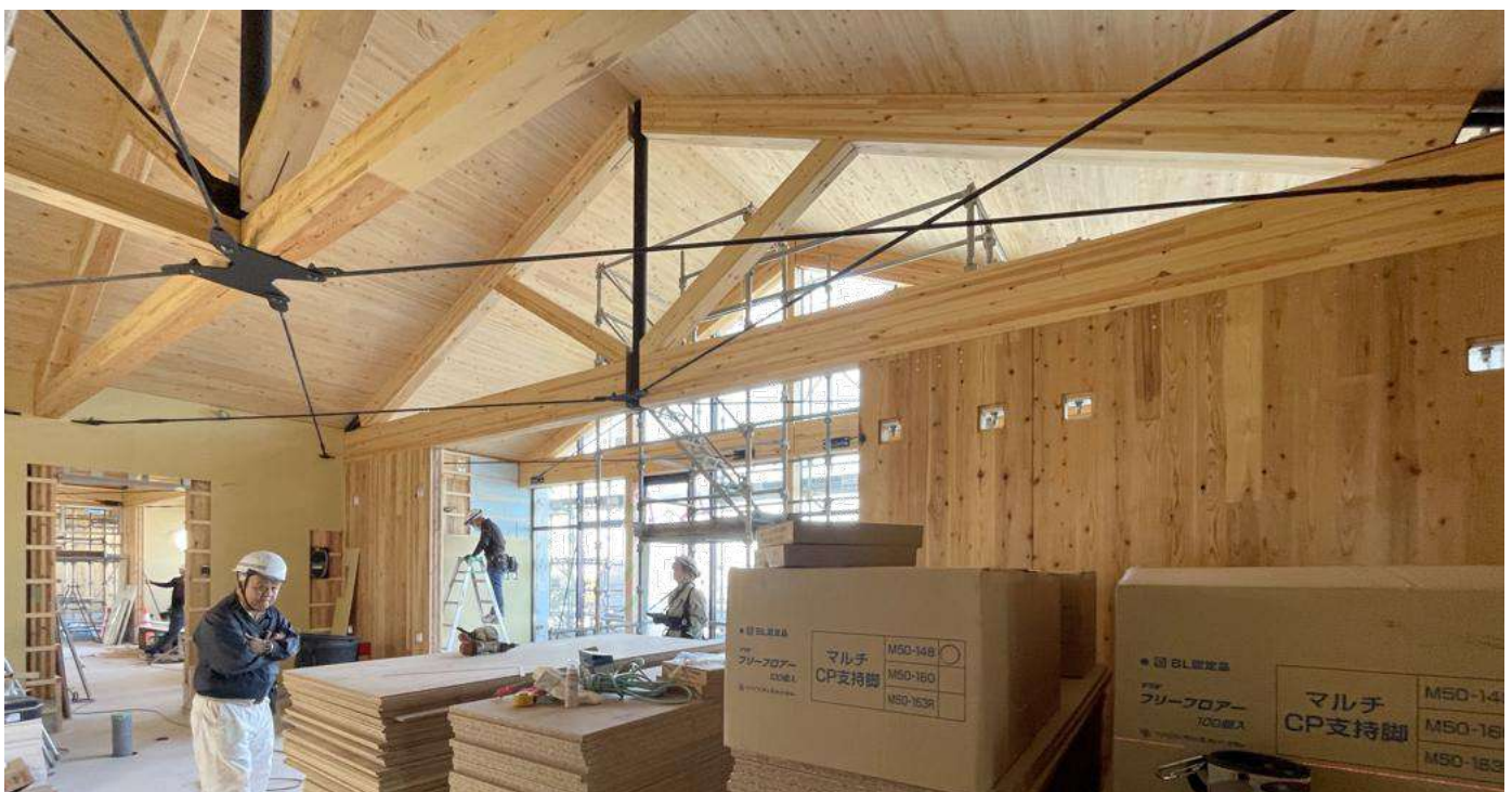
z.香川県産ヒノキを使用したホールのトラスとCLT
