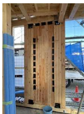
図 1 7 工場施工型 CLT 耐力壁パネル 設置完了写真
