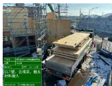
【CLT パネル搬入状況】
