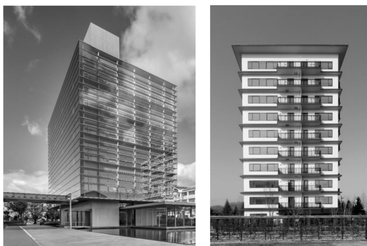
参考写真1 区分1に該当する木造建築物の例（写真は仮） （左：カーテンウォールによるもの、右：外周部が鉄筋コンクリート造等であるもの）
